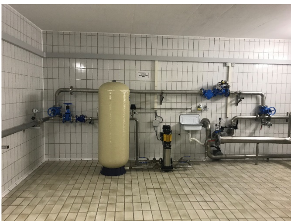
Hochbehälter in Oberhöhenberg
