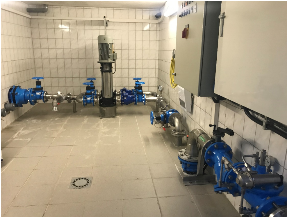
Vor Inbetriebnahme der Quellfassung mussten im Pumphaus diverse Umbaumaßnahmen durchgeführt werden.
