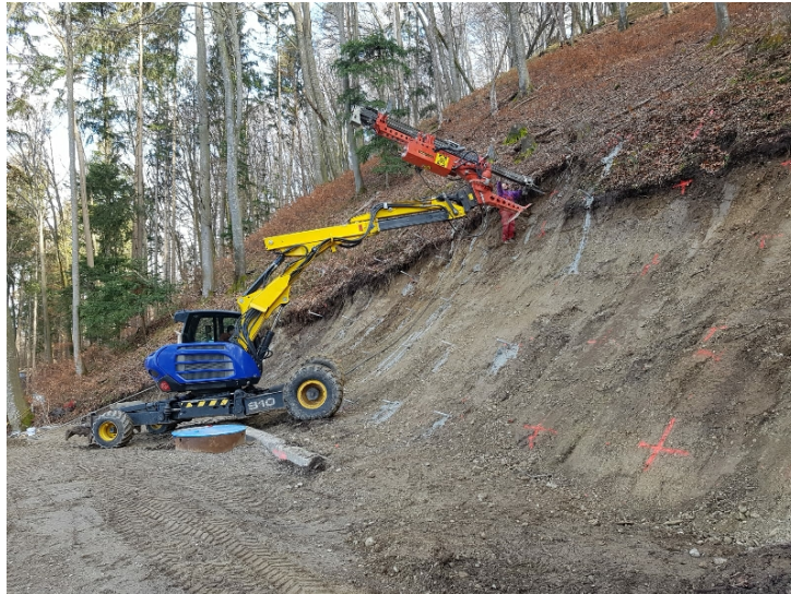
Hangsicherung oberhalb des Quellfassungs-Bereiches, 05.02.2021
