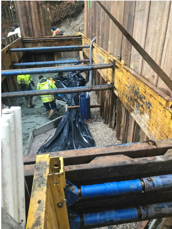
17.03.2021 Errichtung der neuen Quellsfassung
