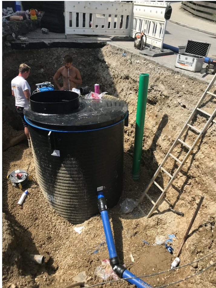
Druckminderer-Schacht am Kreuzberg
