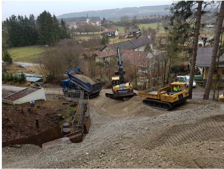
05.02.2021: umfangreiches Aufkieseln der Baustellenzufahrt mit rund 1.400 m 3 Material
