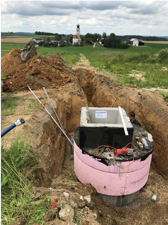
Übergabeschacht in Einharting zum Anschluss der Trinkwasserversorgung der Taufkirchener Gruppe
